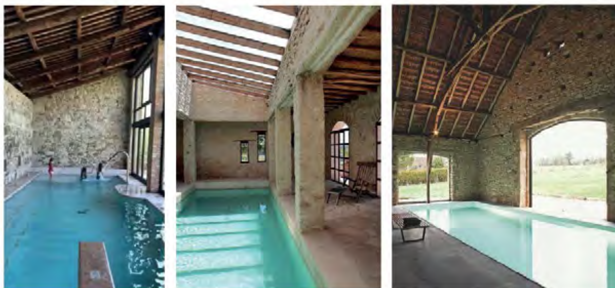
Figure 95 - Aménagement intérieur des halles (source : Espace Gaïa)
