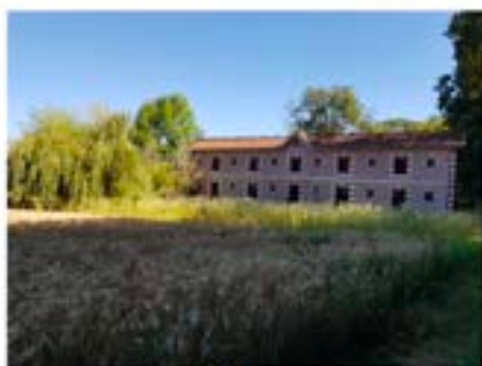
Les bâtiments existants
