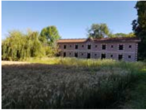
Les bâtiments existants
