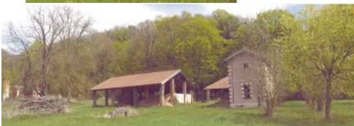
Les deux halles ouvertes
