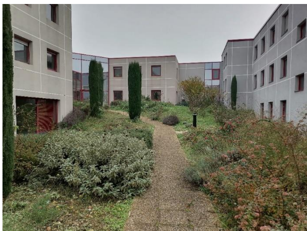
Figure 1 : vue des bâtiments en septembre 2023 avant déconstruction
